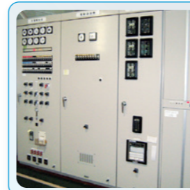
水力発電所水車・ 発電機制御装置
